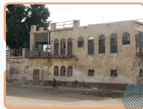
عمارت نجفی- اختلاف سطح بین طبقه‌ی همکف و حیاط با اندود ساروج دیده می‌شود.
