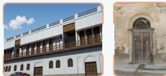
شناشیر- بازسازی نمای خارجی عمارت هفته
