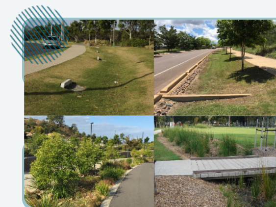
شکل ۸- Vegetated swale با پوشش گیاهی متنوع که در نقش زهکش طبیعی عمل می‌کند.
